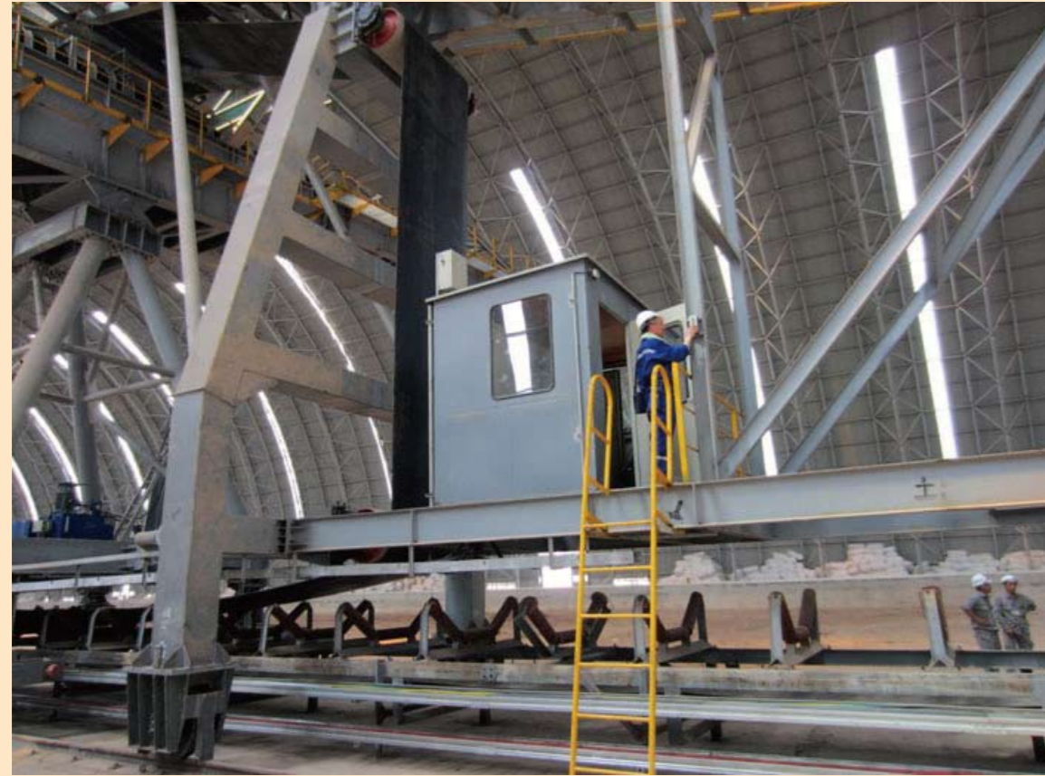
我方工作人员在堆料机上进行操作
